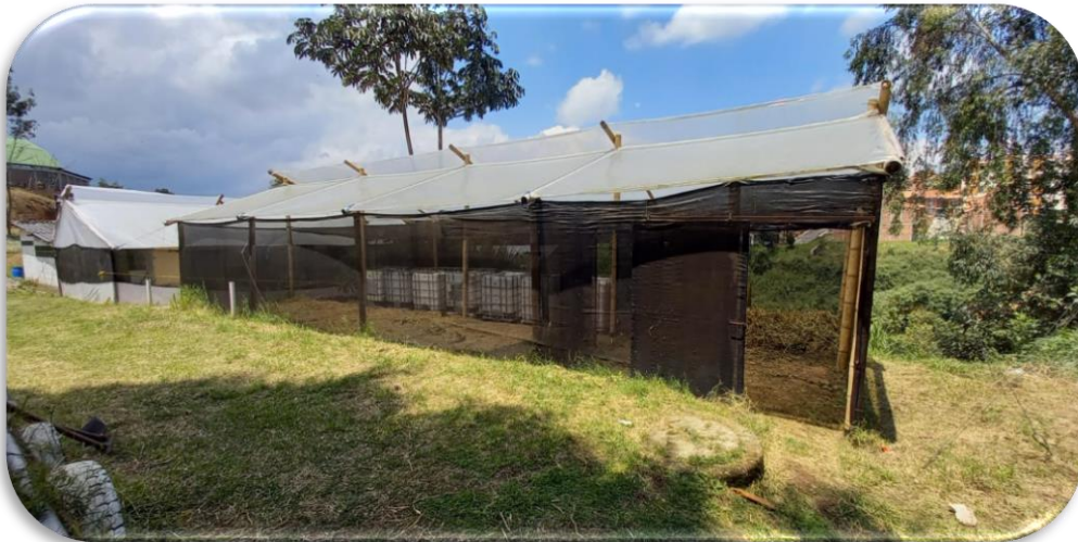
Figura 10. Planta de procesamiento de residuos orgánicos UCO.
